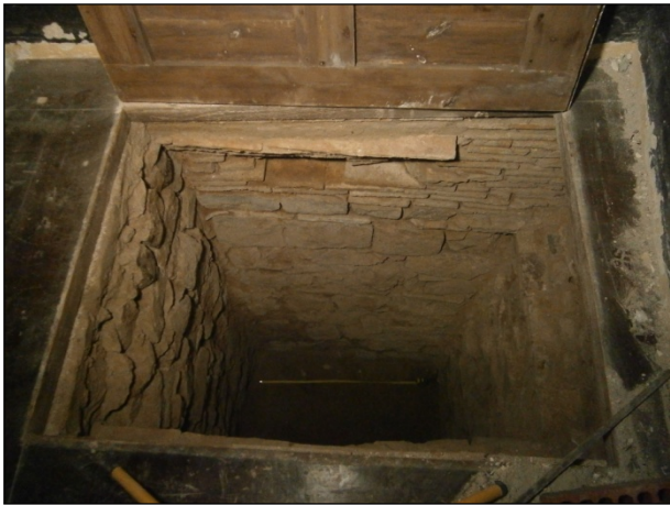
FOTO 11. Un altra vista del dipòsit / sitja UE 208, ara des de l'exterior
