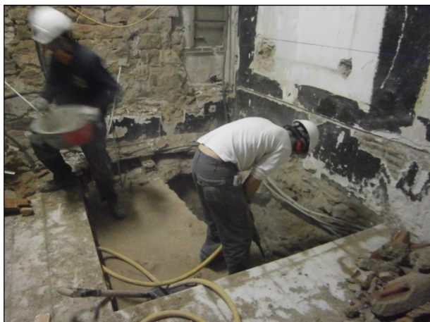
FOTO 17. Eixamplament de la Cala 1 efectuada en la campanya d'octubre de 2013 fins a la mida necessària per a la instal·lació d'un nou ascensor
