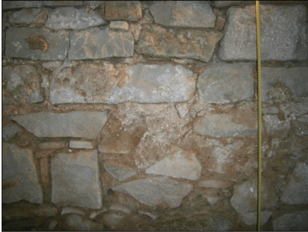
FOTO 13. Detall d'una part del parament de l'interior dels dipòsits / sitges
