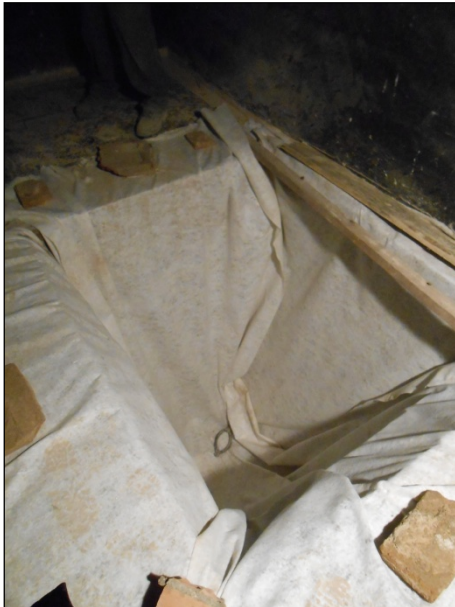
FOTO 23. Col·locació de geotèxtil a l'interior dels dipòsits UE 208 i UE 209
