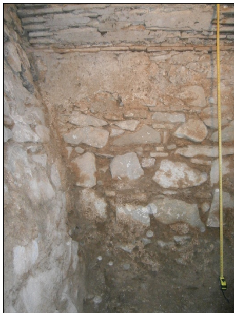
FOTO 15. Paret interior SO del dipòsit / sitja UE 209. Podem apreciar el talús que forma la paret de l'esquerra, situada sota l'espai ocupat per un mur gòtic
