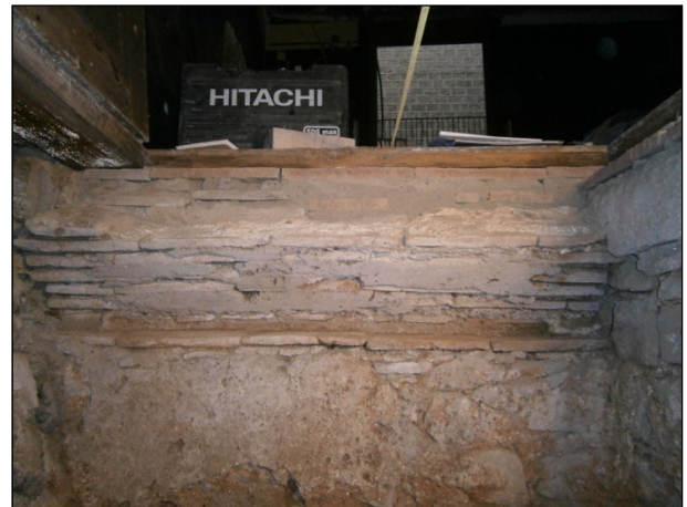
FOTO 16. Detall de la volta de sardinell escapçada al costat SO del dipòsit / sitja UE 209
