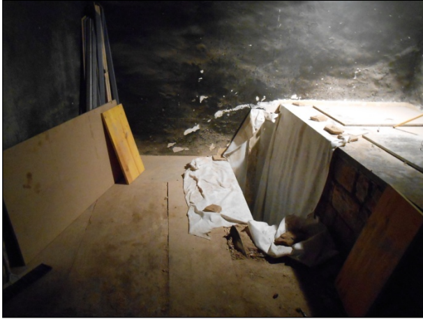
FOTO 21. Col·locació de geotèxtil a l'antiga cala
