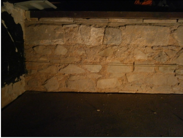
FOTO 9. Detall del parament exterior de la part del dipòsit UE 208 que sobresortia del terra
